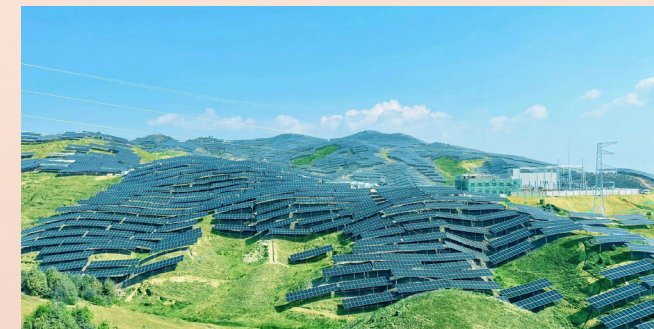
国投云南新能源茂兰光伏项目
