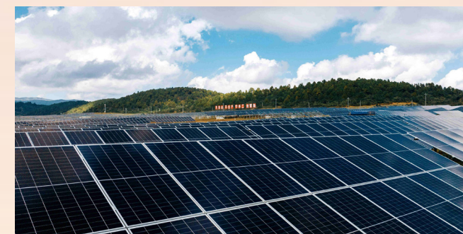
正在建设中的雅砻江扎拉山光伏电站
